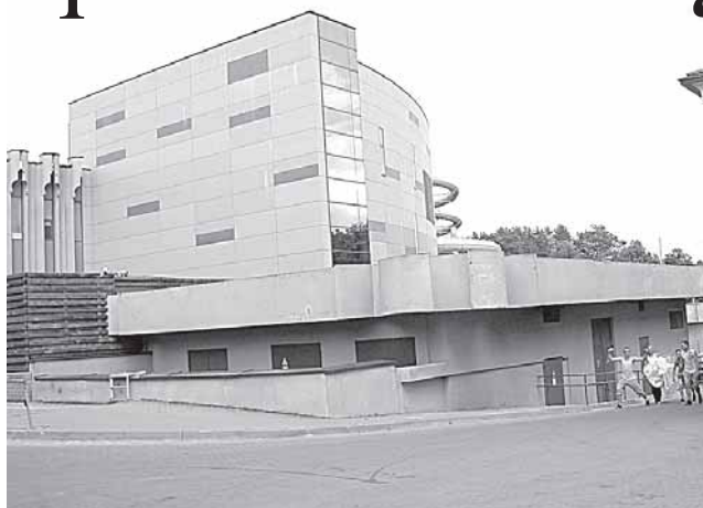
Virš šios transformatorinės iškilis 3 viešbutio aukštai
