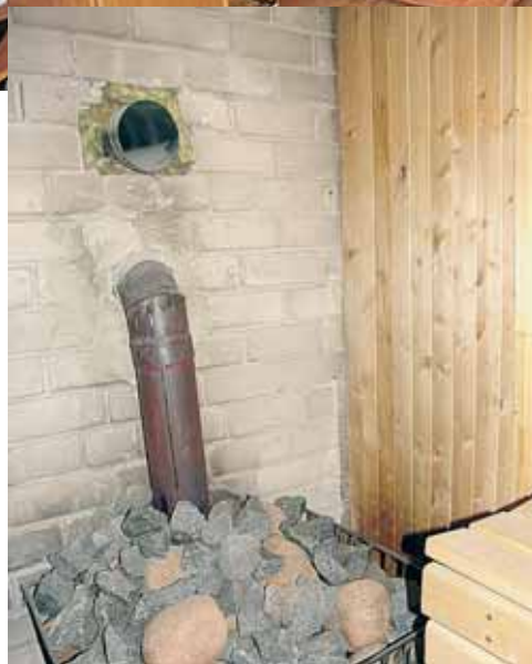
Šiluma į jaukių Eugenijaus Urbanavičiaus namų kambarius patenka iš saunos patalpos įmontuotu sienoje specialios cinkuotos skardos vamzdžiu
