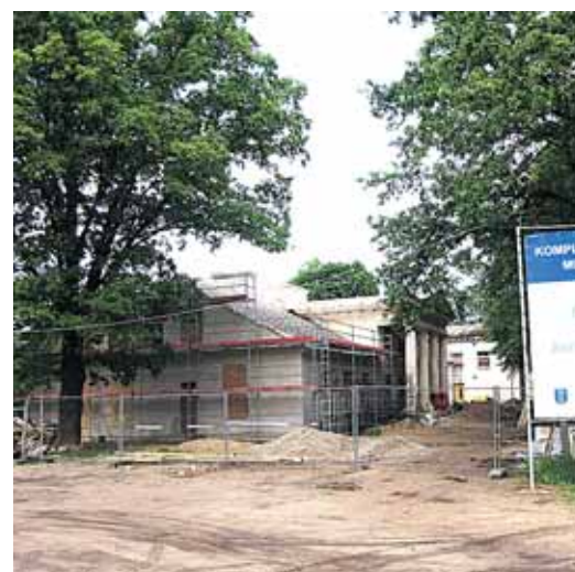
Restauruojami Leipalingio dvaro rūmai
