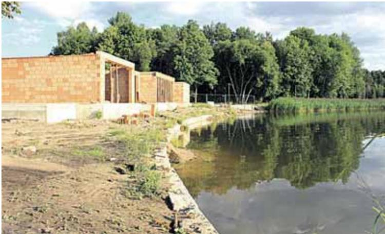
2013 m. liepos 31 d. Iš gelžbetonio blokų suformuota sienelė (krantinė) ant vandens linijos. Pastato užstatymas - 3,8 m nuo vandens linijos
