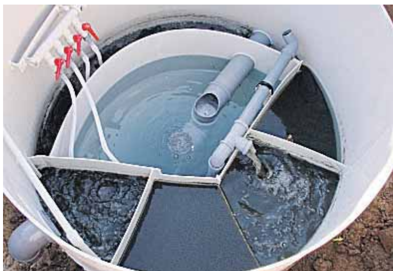
V.Semeškos namo kieme įrengtas pažangus „August ir Ko“ buitinių nuotekų valymo įrenginys AT-8
