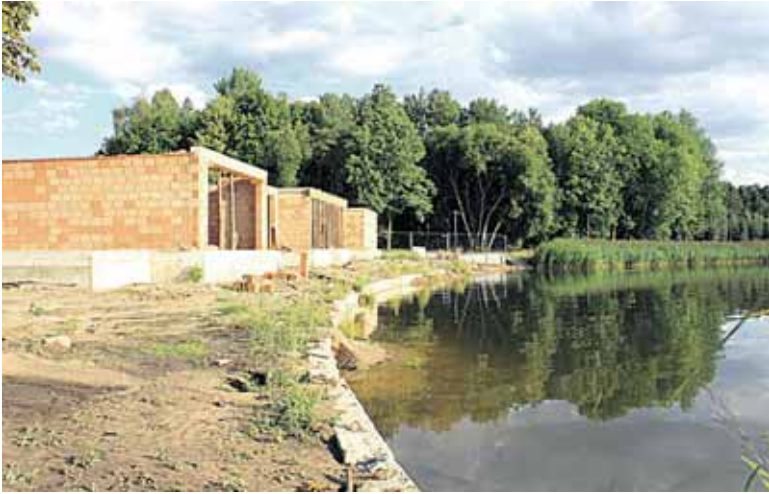
2013-07-31. Iš gelžbetonio blokų buvo suformuota sienelė (krantinė) ant vandens linijos. Pastato užstatymas tuomet buvo 3,8 m nuo vandens linijos
