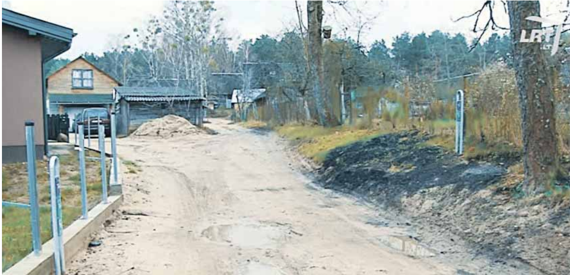
Nuotekų tinklo tiesimo darbai Ratnyčioje
