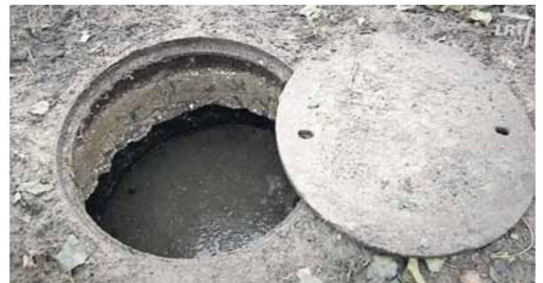
Iškasta nuotekų duobė, vadinamasis septikas, Vijūnelio pakrantėje
